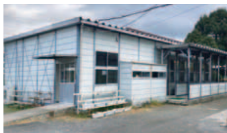
老朽化している陵南小学校仮設校舎
