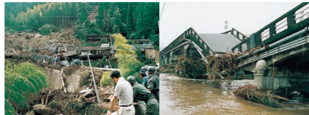
隼人町松永地区で民家を直撃した土砂崩れ
