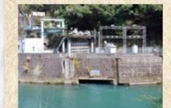
明治36(1903)年に山ヶ野金山の第7代鉱業館長に就任した五代龍作(友厚の養子)が金山から30km離れた天降川に建設した発電所の跡。石造りの建物は新しく建て替えられたが、水路などは現在も使われている。
