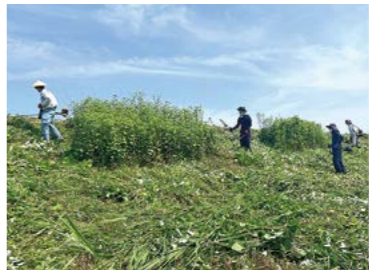
堤防の草刈り作業の様子
