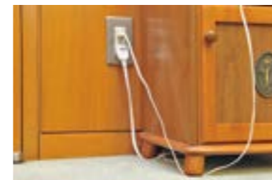
棚の下敷きになっている電源コード
