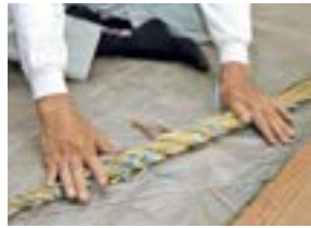
⑤飛び出たわらを切って完成
