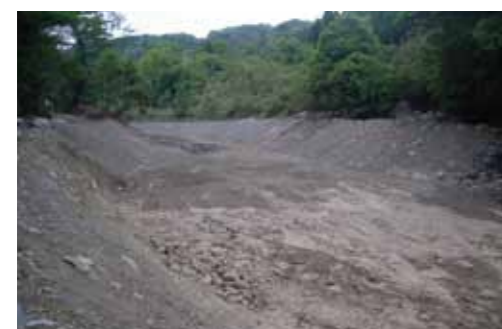
除石工事を行った霧島川6号堰堤(霧島神宮付近)
