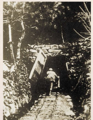
トロッコ導入前の西浜坑口（尚古集成館所蔵）
