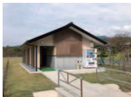
霧島高原国民休養地 トイレ新築工事
