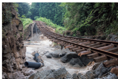
土砂崩れによって宙に浮いた線路（表木山駅付近）
