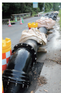
応急対応をした導水管
