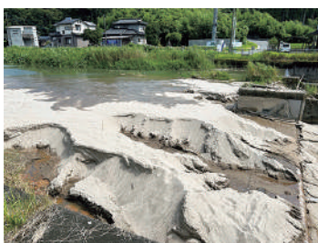
堰内の土砂堆積状況
