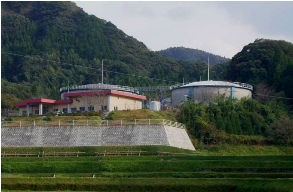
国分台明寺配水池
