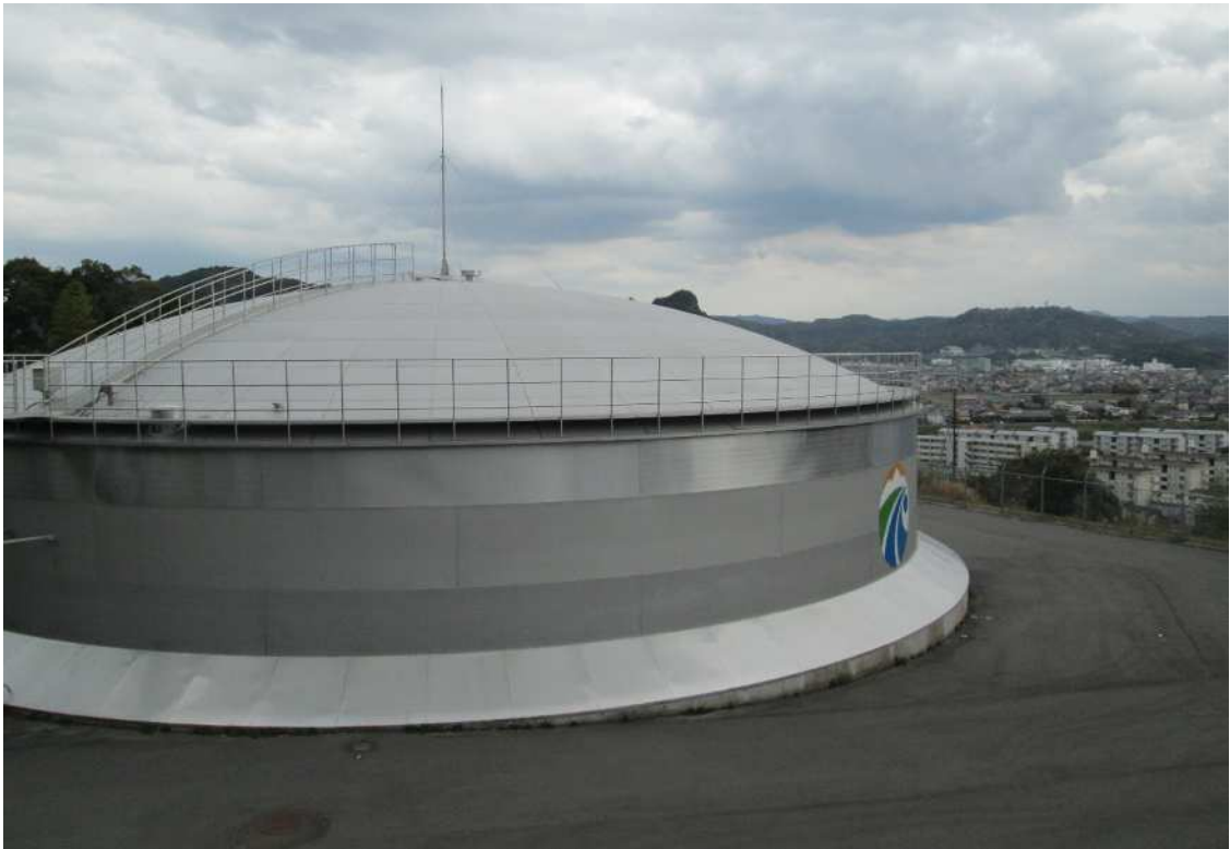
隼人木之房配水池
