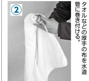
② タオルなどの厚手の布を水道管に巻き付ける。
