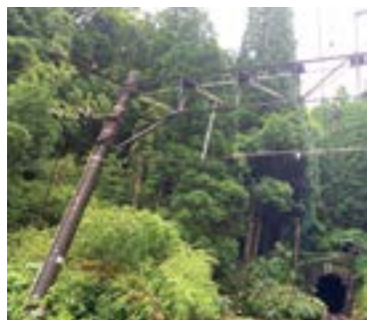
倒木が原因で傾いた電柱
