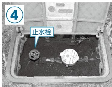
水道メーター器ボックス内の止水栓を確認。右に回すと水が止まる。
