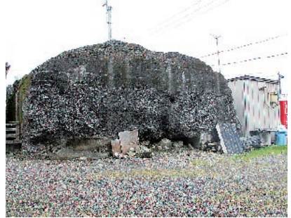
第一国分基地の発電所跡
