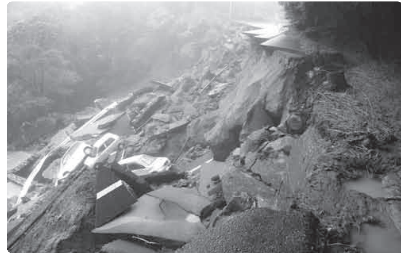
国分重久の道路陥没現場。乗用車4台が約30cm下に転落。
