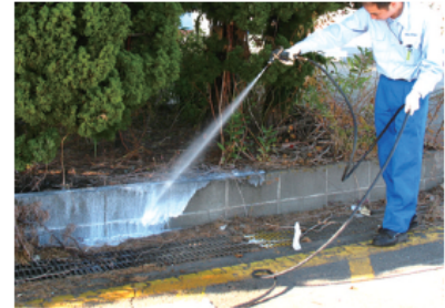
専門業者による液剤の高圧散布
