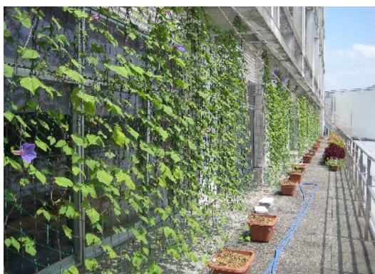
霧島市役所 国分庁舎
