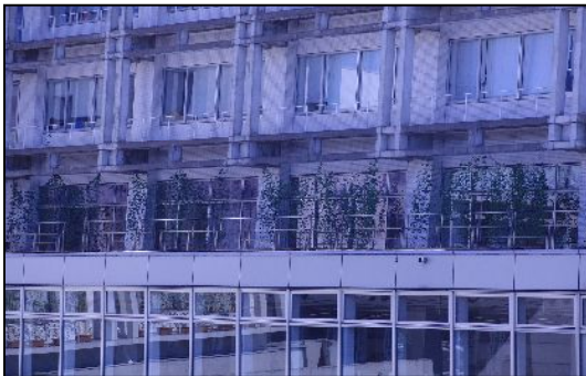
霧島市役所国分庁舎
