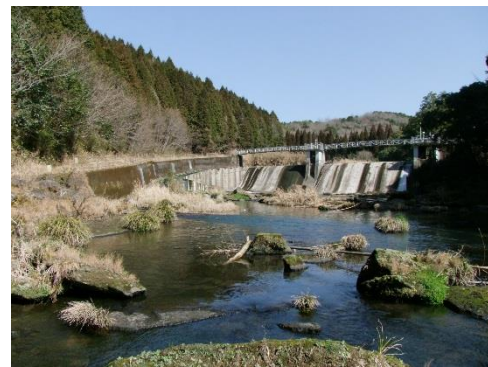
塩浸発電所の取水ダム
