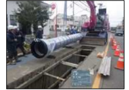
(耐震管の敷設工事)
