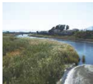
侏儒どん橋下の河川状況
