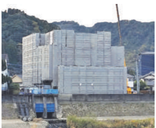
姫城2号樋門と建設中の排水機場
