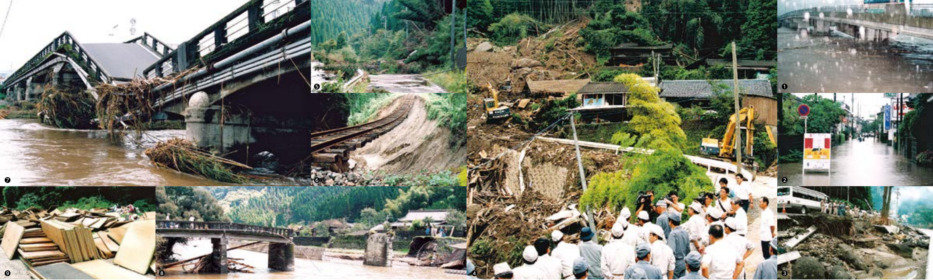
①水位が高まっている若船橋(隼人町東郷)②冠水した市街地(隼人町日当山)③川の水が岸を削り、道路まで迫った(妙見大橋近く)④土砂崩れが民家を直撃。5人の尊い命が失われた(隼人町松永)⑤土砂崩れによって寸断された道路(隼人町松永)⑥土砂崩れによって宙に浮いた線路(表木山駅近く)⑦濁流により崩壊した日当山橋(隼人町東郷)⑧落橋した上小鹿野橋(隼人町松永)⑨水難ごみ置き場に積まれた大量の量
