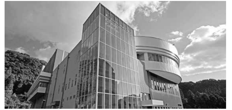
令和8年3月1日に供用開始した市クリーンセンター
