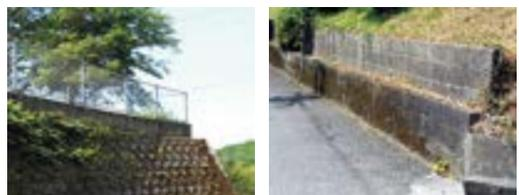
擁壁の上部に直接設置されている 土留めを兼ねている
