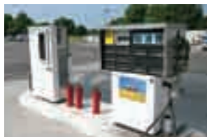
天降川リサイクルセンター内にはガソリンスタンドと同じように軽油と代替燃料を給油する装置があります。
