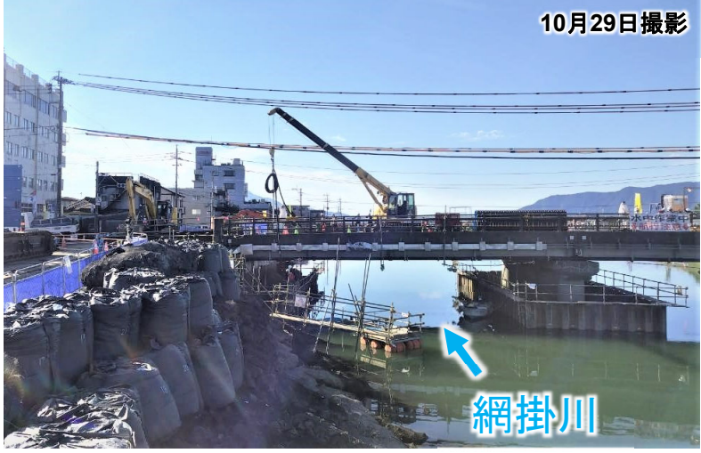
応急復旧（施工中）
