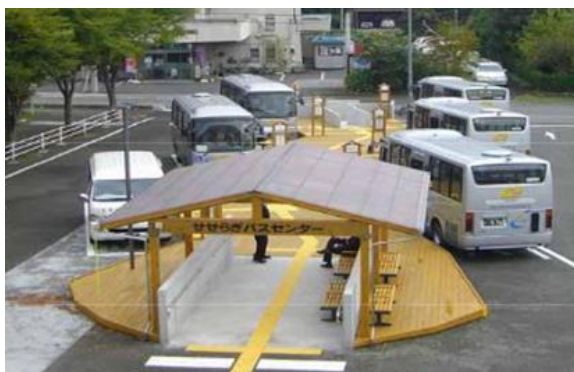
図 「せせらぎバスセンター」 (埼玉県ときがわ町)
