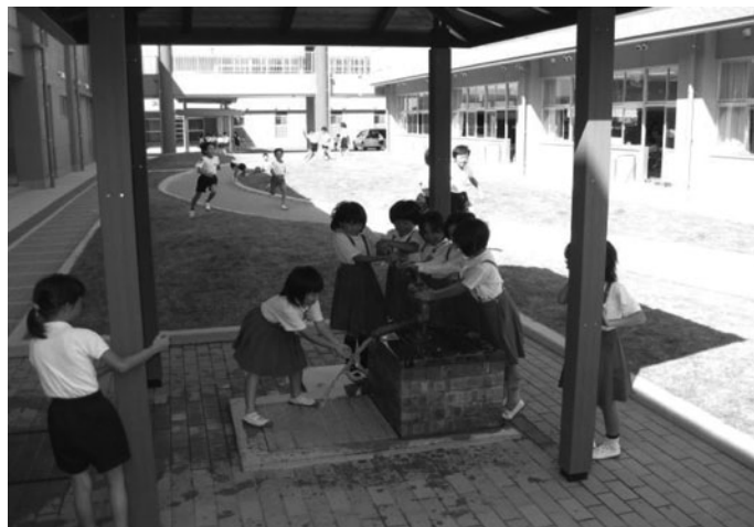
雨水利用の手押ポンプ
