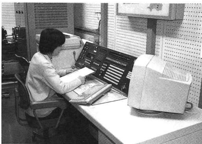
防災行政無線 放送室
