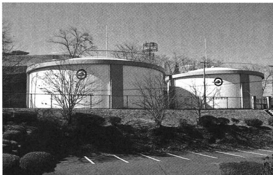
上水道配水池増設
