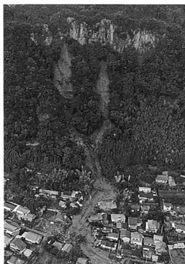
写真 1-32 姫城におけるがけ崩れの発生状況
