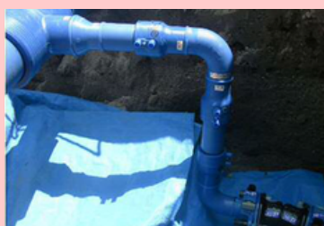
水道管の耐震化
