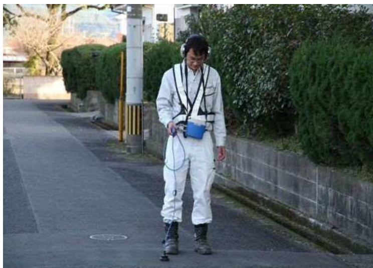
漏水調査状況
