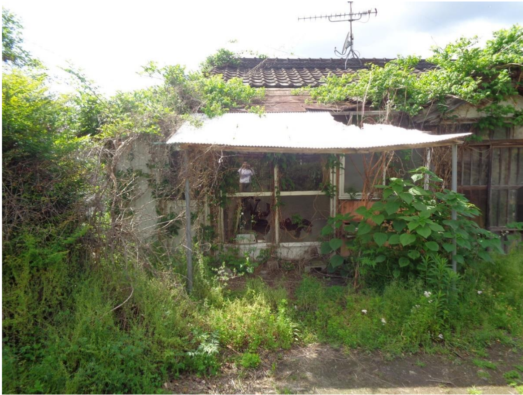
現況写真⑦
