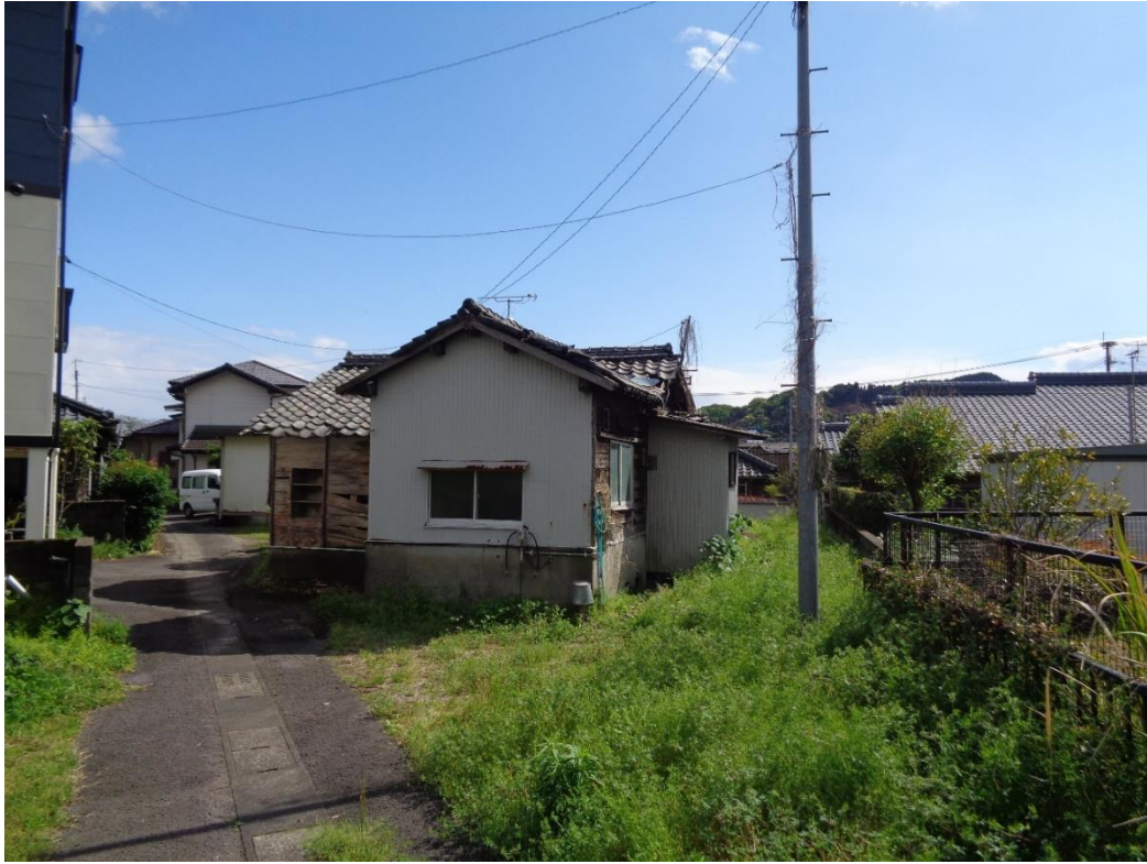
現況写真①
