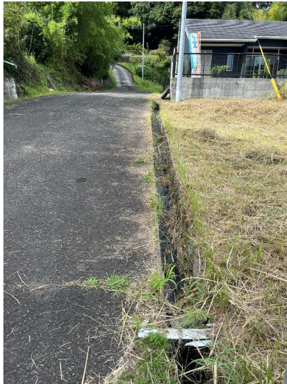
現況写真⑦
