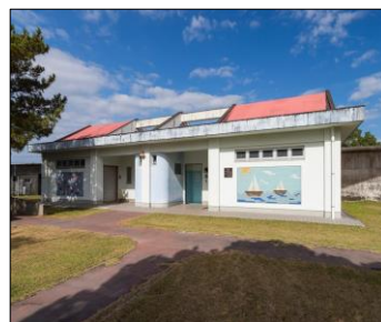
トイレ・シャワー棟
